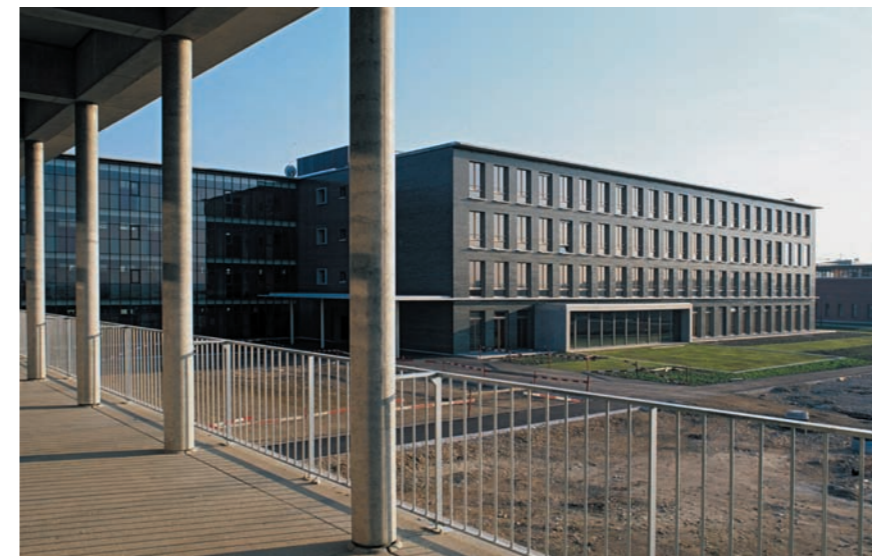
Terrasse Sepp-Glaser-Sporthalle - Ansicht Südwest
