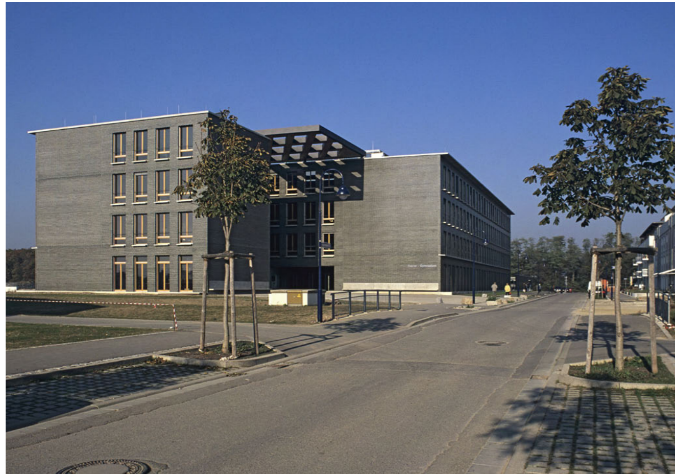
Kepler-Gymnasium Freiburg im Breisgau, Johanna-Kohlund-Strasse 5 - 1997
